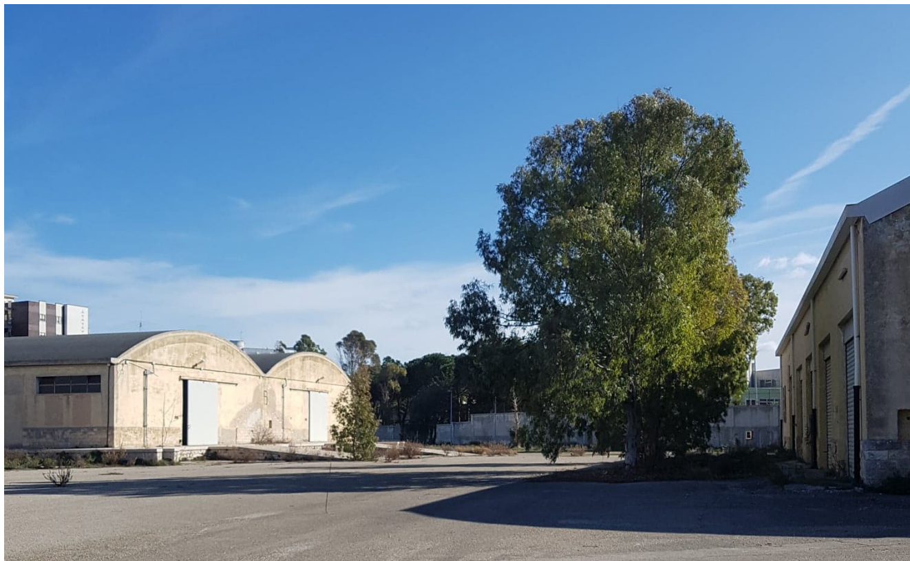
Vista dello spazio antistante i capannoni Ex Deposito Carburanti - Monopoli (BA)
