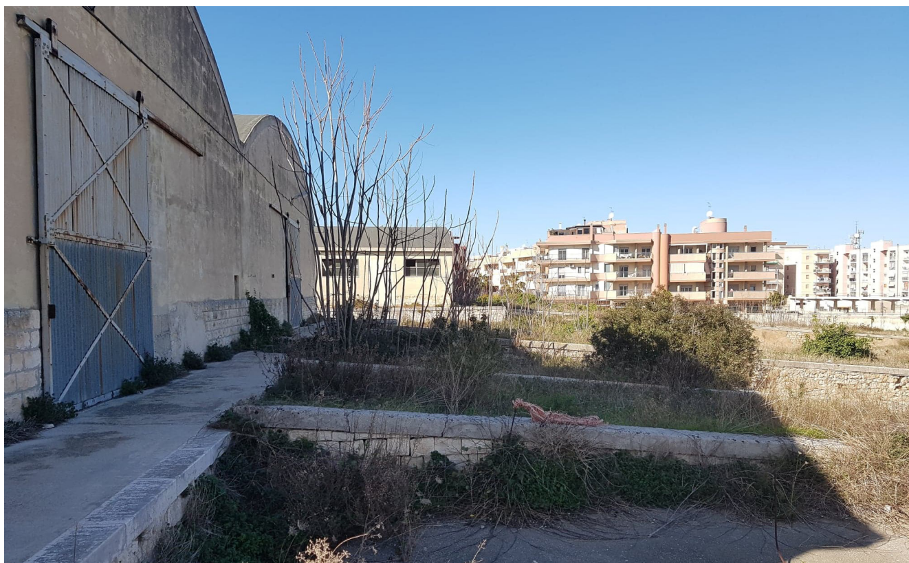
Vista dello spazio esterno retrostante (rampe) Ex Deposito Carburanti - Monopoli (BA)
