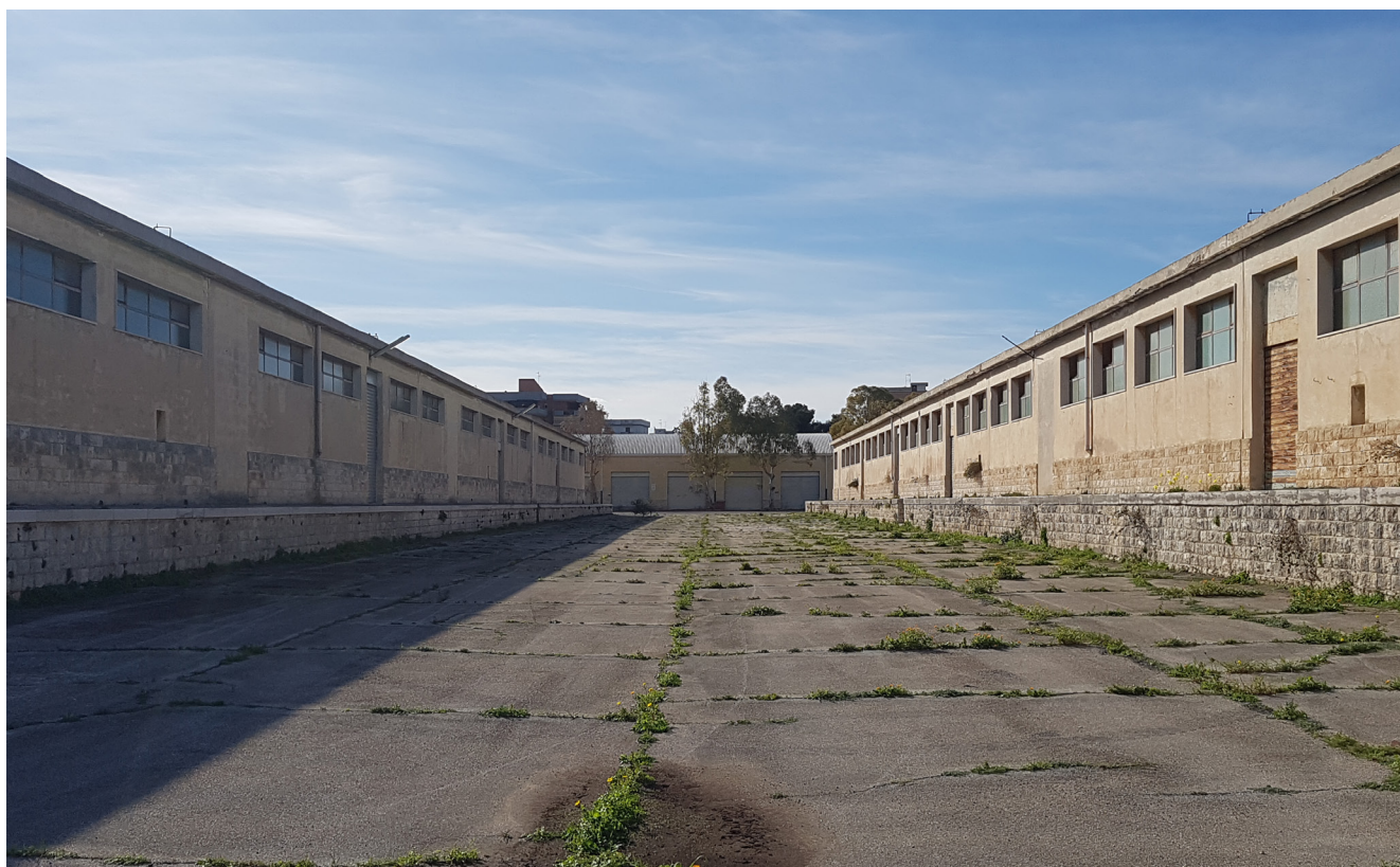
Vista dello spazio aperto tra i blocchi dei capannoni Ex Deposito Carburanti - Monopoli (BA)
