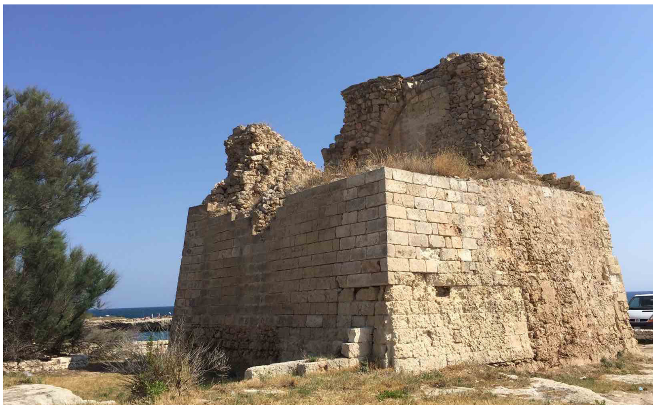
Vista di Torre Cintola Monopoli (BA)
