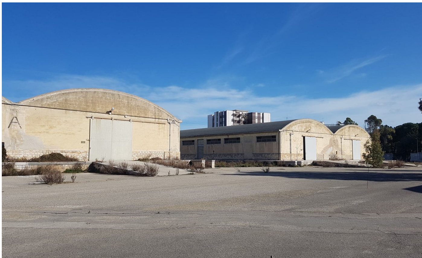
Vista del piazzale anteriore ai blocchi capannoni Ex Deposito Carburanti - Monopoli (BA)
