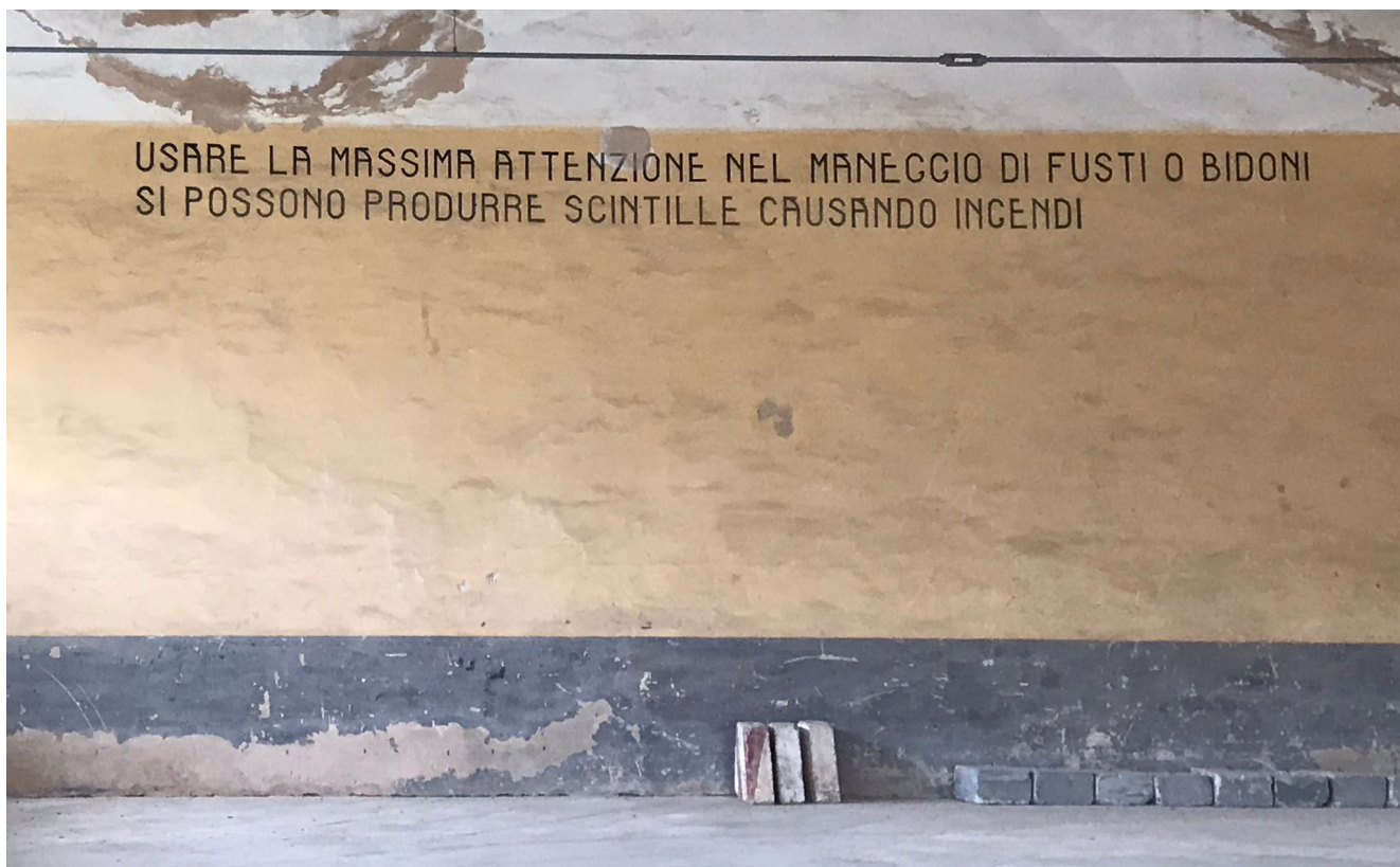
Vista dello spazio interno parete di delimitazione Ex Deposito Carburanti - Monopoli (BA)
