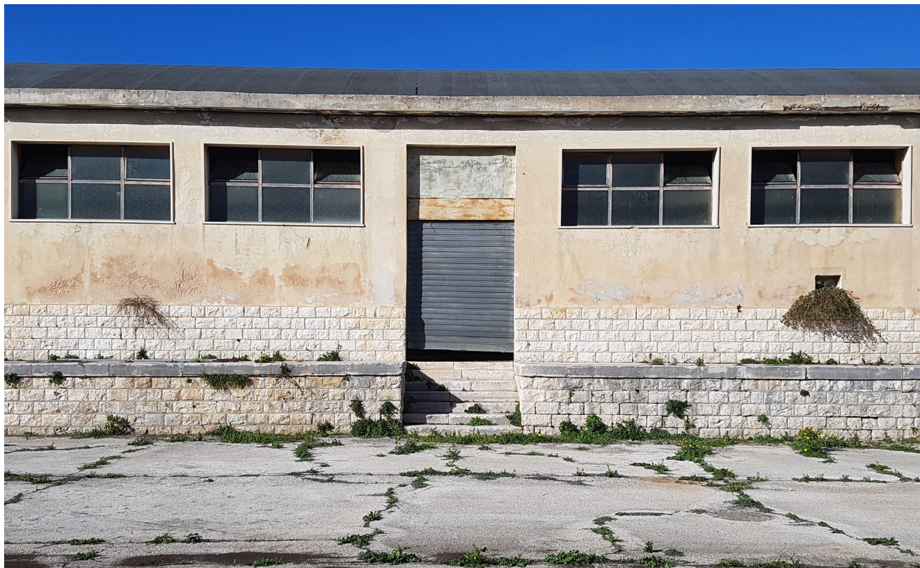
Vista parziale del prospetto laterale tipo dei capannoni Ex Deposito Carburanti - Monopoli (BA)
