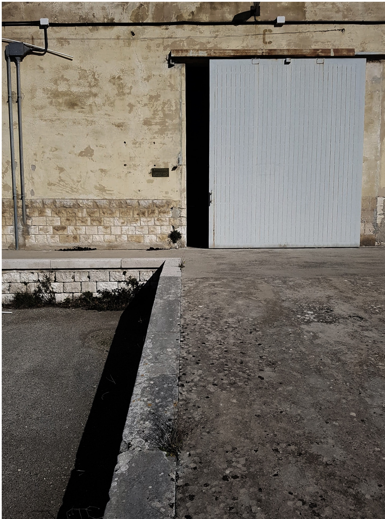
Vista di dettaglio del portale d'accesso dei capannoni Ex Deposito Carburanti - Monopoli (BA)
