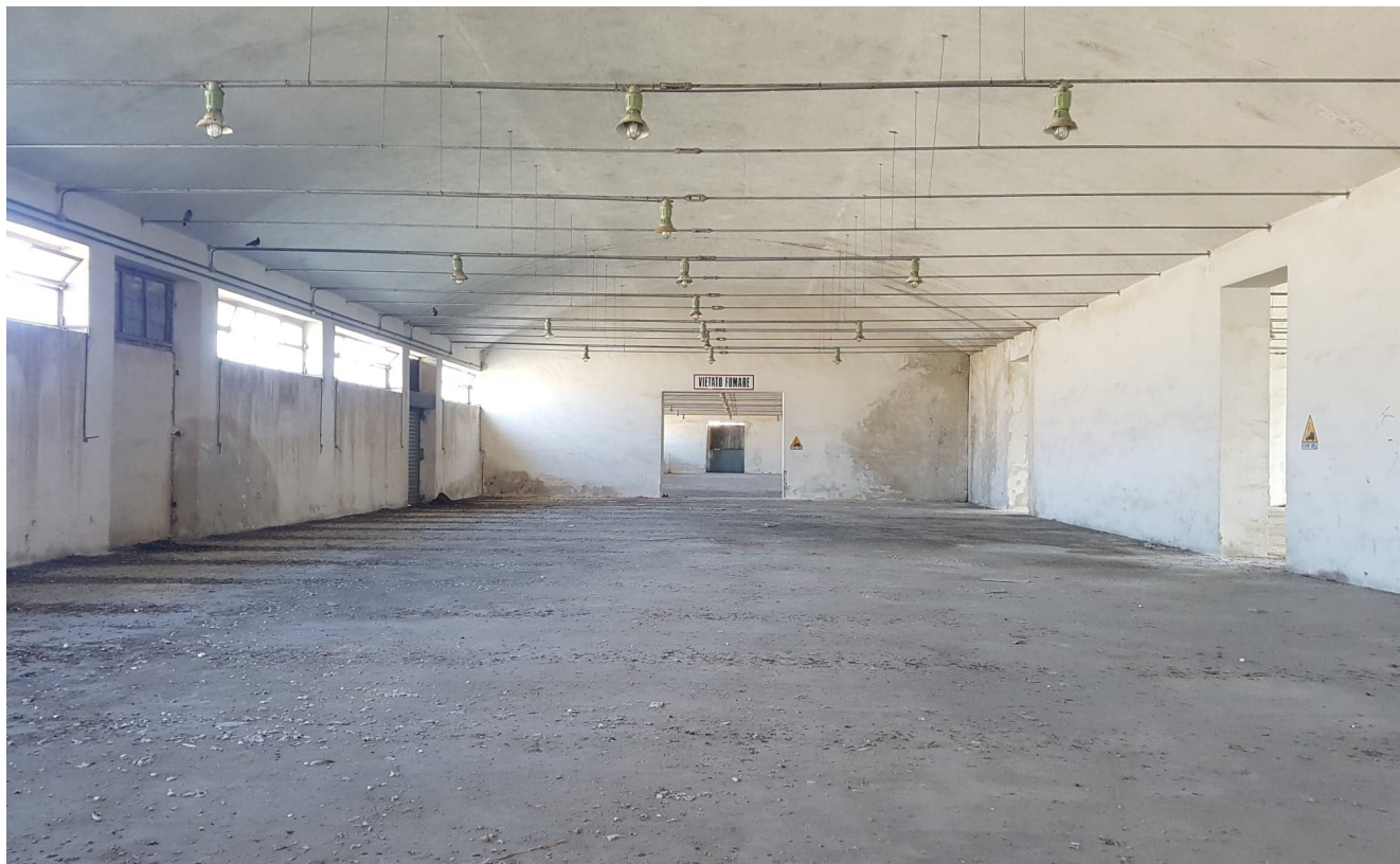
Vista interna di uno dei quattro capannoni Ex Deposito Carburanti - Monopoli (BA)
